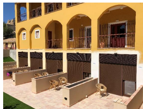
◀ Ampliación y mejora tras la segunda certificación parcial. Fuente: Integral
