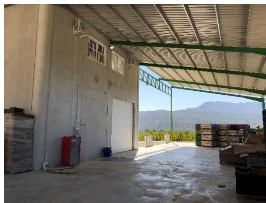
◀ Estado operación tras certificación parcial Fuente: Integral
